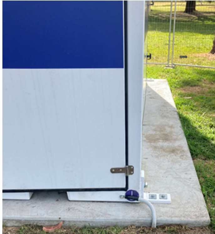
Figure 16: Terminating equipotential grounding cables.
